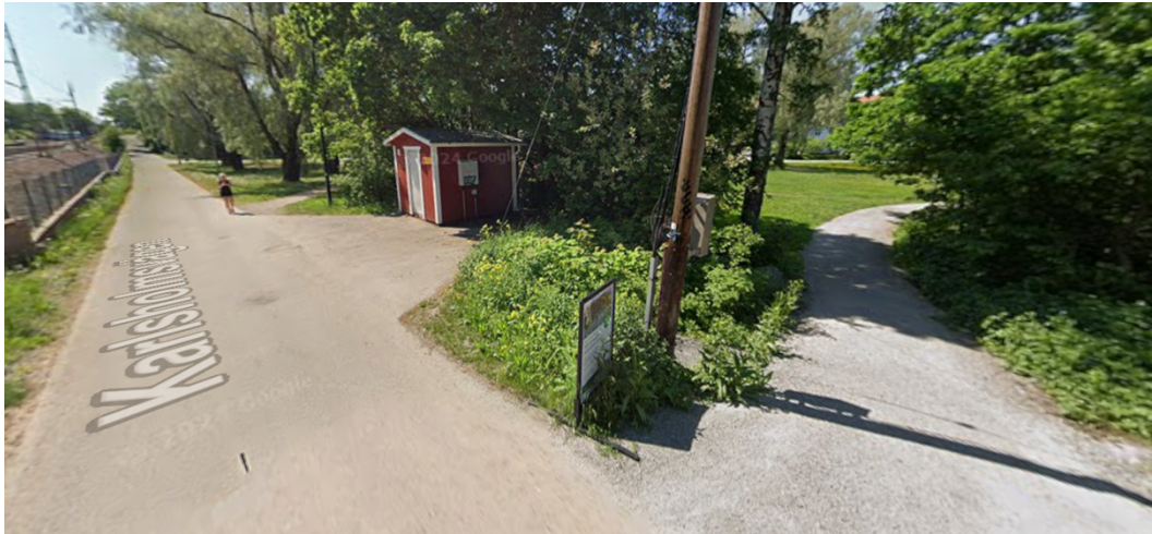
Figur 2: Bild på pumpstationen på Karlsholmsvägen 15
