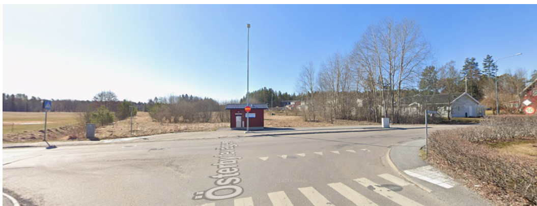
Figur 1: Bild på pumpstationen på Jarlabankes väg 33
