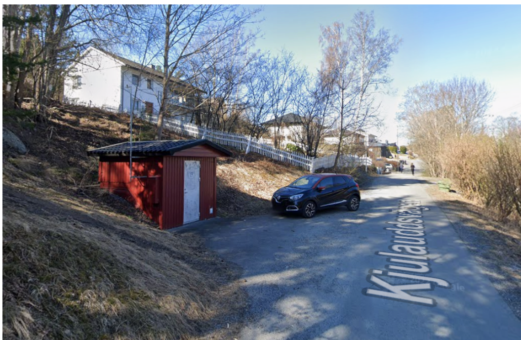
Figur 4: Bild på pumpstationen på Kjulauddsvägen 9
