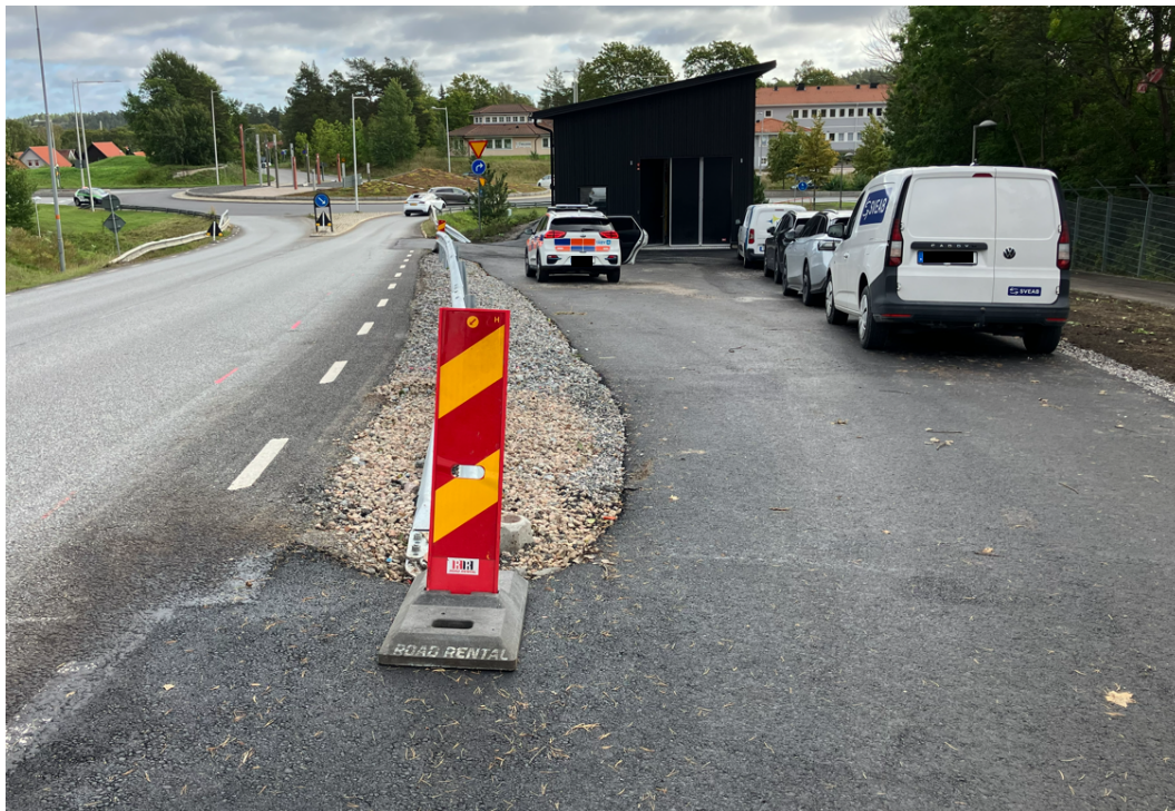
Figur 5: Bild på pumpstationen på Stockholmsvägen 230
