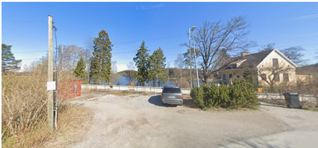
Figur 3: Bild på pumpstationen på Kjulauddsvägen 22
